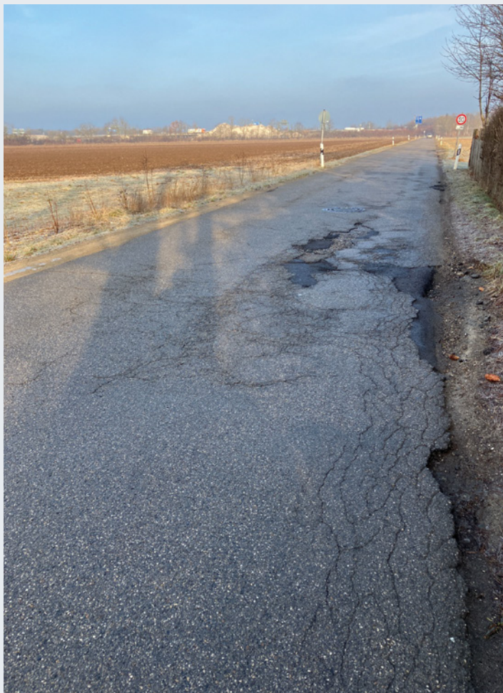
Beim Ammerthaler Weg in Weißenfeld müssen die Asphaltschicht und die Bankette erneuert werden.
